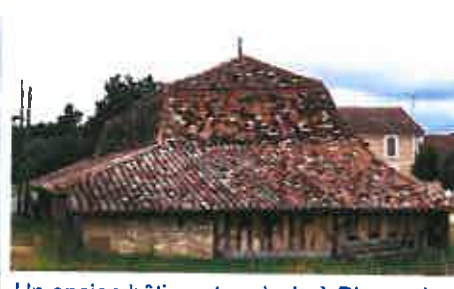
Un ancien bâtiment agricole à Bigoussias.
